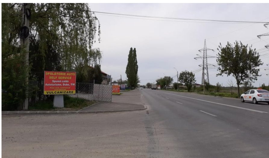
DN 72 – Soseaua Gaesti – strada asfaltata – 4 benzi
