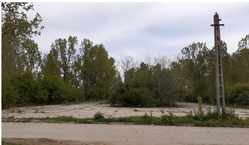
8. Zona parcare in stare de degradare
