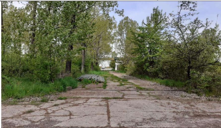
4. Drum incinta care nu deserveste nici o activitate – drum betonat - profil 5,5m
