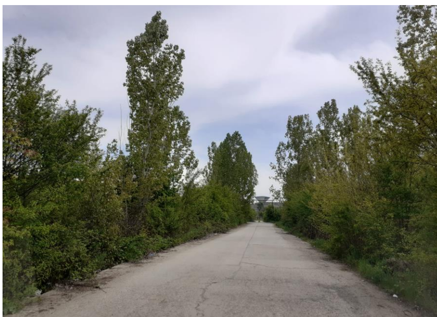
3. Drum incinta care nu deserveste nici o activitate – drum betonat - profil 5,5m
