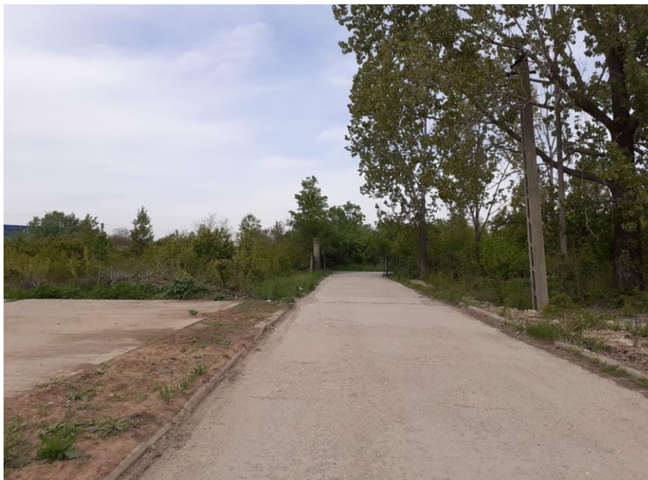
7. Drum acces SC SORCLAS SRL si Firma curierata GLS - drum betonat - profil 5,5m si spatii verzi de 1,5 m care se doreau a se amenaja ca trotuare
