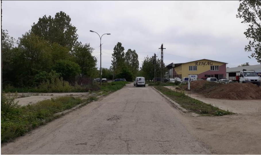
7. Drum acces SC SORCLAS SRL si Firma curierata GLS - drum betonat - profil 5,5m si spatii verzi de 1,5 m care se doreau a se amenaja ca trotuare
