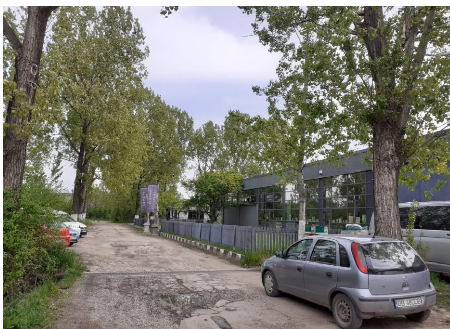
6. Drum acces si zona parcare SC QUADRA INVEST SRL – drum betonat - profil 5,5m
